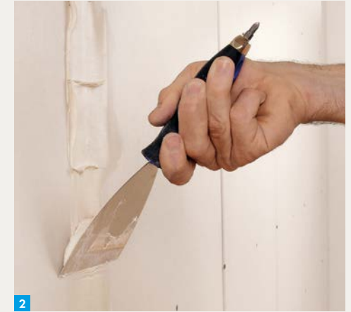
2. Mit dem Schraubgriffspachtel scharf abziehen.
